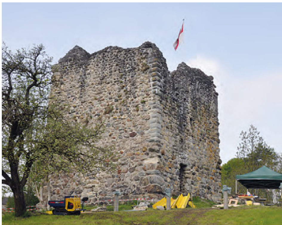
Die Ruine Last ist von angehenden Mauern und Strassenbauern saniert worden.
