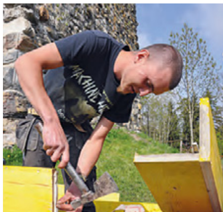
Ein Maurerlehrling bei Schalungsarbeiten für die Betonpfeiler, durch welche eine Kette rund um die Ruine angebracht wird.
